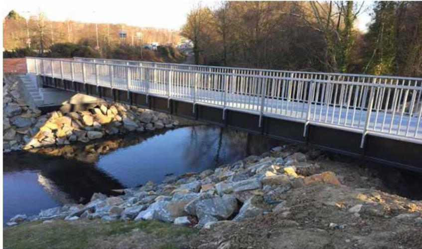
Figure 37 : Exemple de passerelle de type quadri-poutres (Passerelle de Gesvres (44-Nantes))
